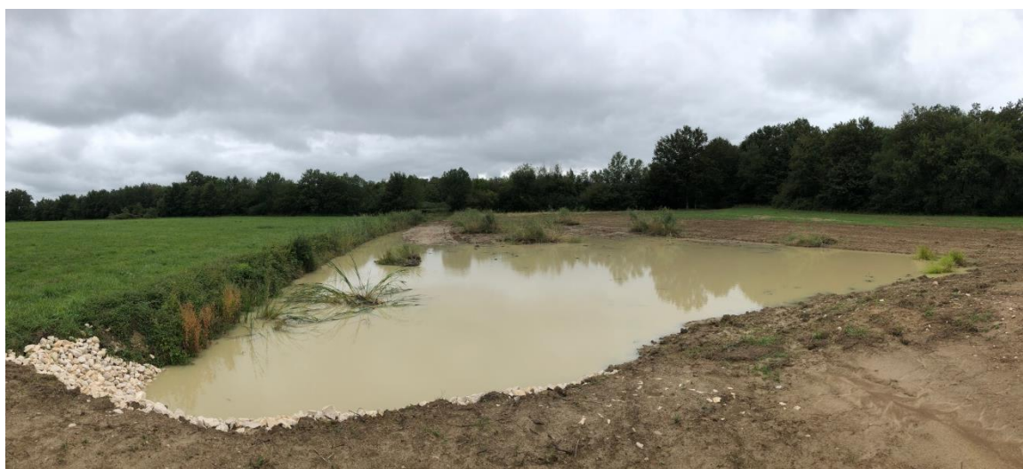
PHOTO 4 : ELARGISSEMENT LOCALISE D'UN FOSSE ET CREATION D'UN DISPOSITIF EN PENTE DOUCE
