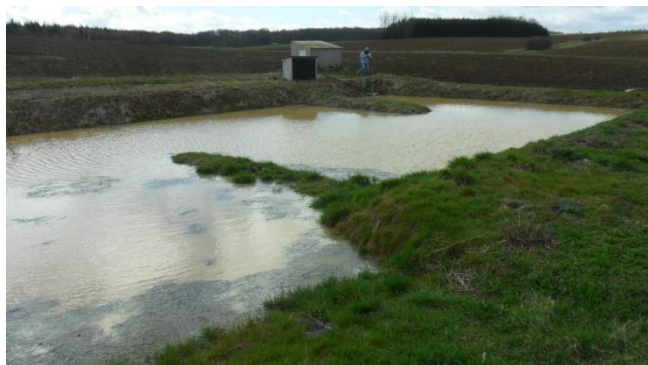
PHOTO 2 : « MARE EN S » DESTINEE A RALENTIR LE FLUX D'EAU ET FAVORISER LES PROCESSUS DE RETENTION / EPURATION
