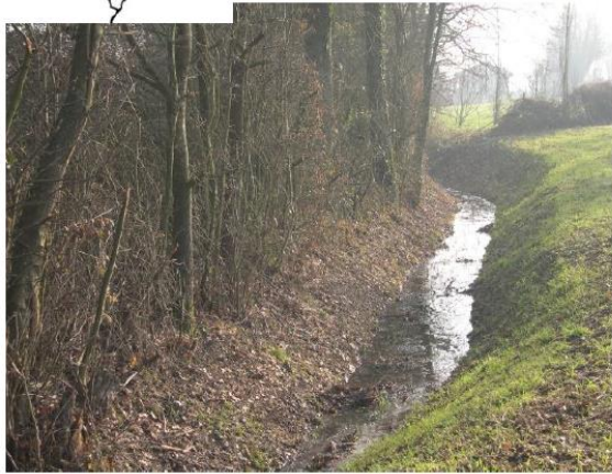
Fossé de ceinture de l'étang Charbonnière (Châtillon sur Chalaronne)
