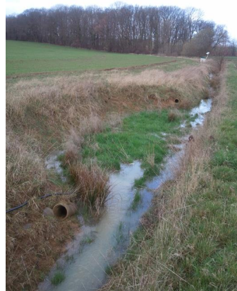
PHOTO 2 : « MARE EN S » DESTINEE A RALENTIR LE FLUX D'EAU ET FAVORISER LES PROCESSUS DE RETENTION / EPURATION
